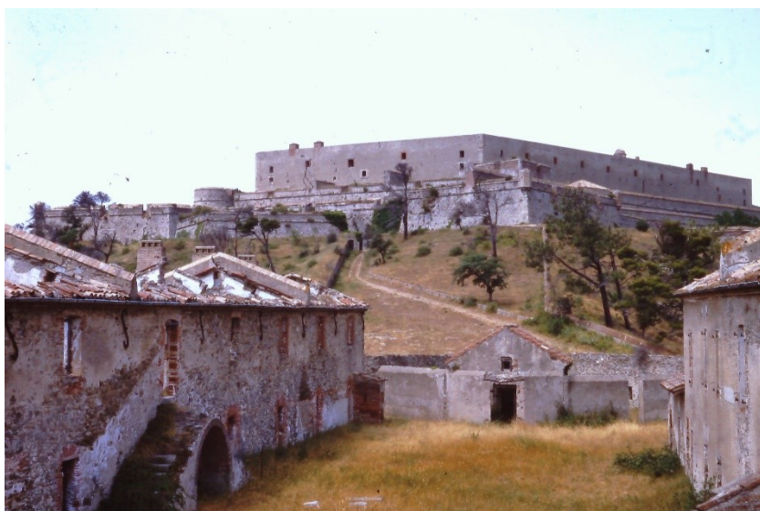
Fig. 4. Le fortin de Bellegarde. Vue sur Bellegarde, front sud. Cl. Georges Castellvi, 1986.
